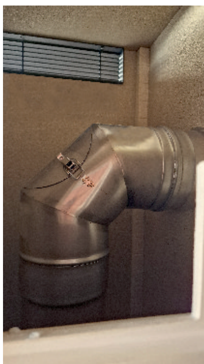
Detail zadního napojení na komín
